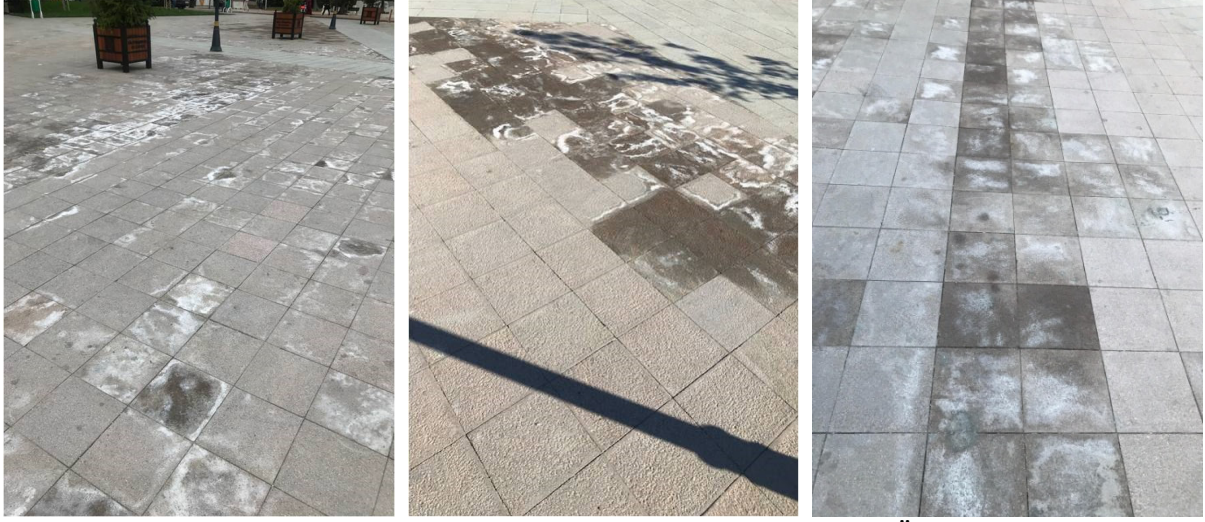
Şekil:20 Andezit Plak Taş Bozulma ve Küflenmeler (Fotoğraf: Ülker Barış, 2019)
