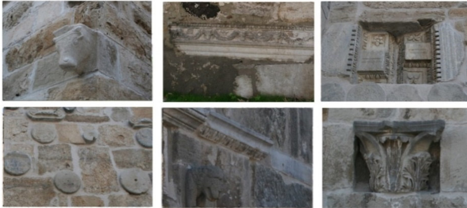
Şekil 7. Surların içerisinde bulunan mimari devşirme elemanlar
