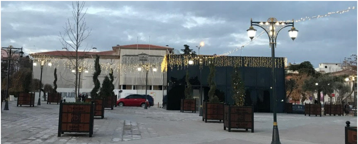
Şekil:14 Restorasyonu devam eden Tarihi Valilik Binası ve Onun görüntüsünü engelleyen Otopark Çıkışı (A) (Fotoğraf: Ülker Barış, 2019)
