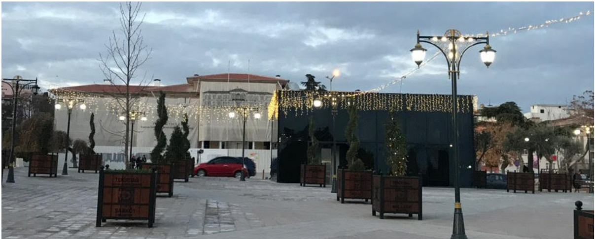
Şekil:14 Restorasyonu devam eden Tarihi Valilik Binası ve Onun görüntüsünü engelleyen Otopark Çıkışı (A) (Fotoğraf: Ülker Barış, 2019)
