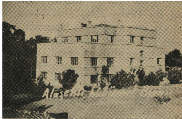
Şekil 12. Alaşehir Hükümet Konağı (Akıncı, 1949)
