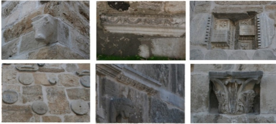
Şekil 7. Surların içerisinde bulunan mimari devşirme elemanlar
