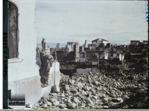
Şekil 10. Yangın Sonrası Yerleşimde Oluşan Yıkıntılar (08.01.1923) (Albert Kahn Müze Arşivi)
