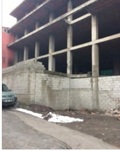
Resim 20. Pazarkapı Mahallesiinde altıncı evin yerindeki karkas inşaat(Şubat 2017, N. Aydın Fotoğraf Albümü)
